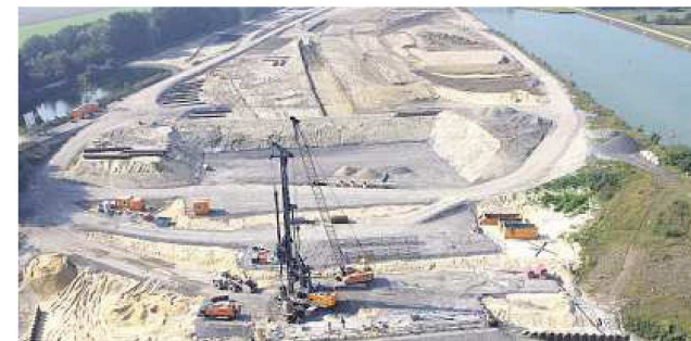
Die derzeit größte Baustelle für das Flosser Unternehmen ist die Umfahungsstrecke am Neubau der Kanalbrücke Ems als Teil des Dortmund-Ems-Kanals.
