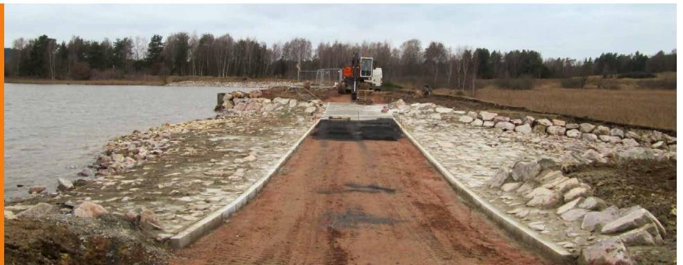
Die Aufgabenstellung bestand darin, die Standfestigkeit der Deichböschung durch den Einbau von Spundwänden und großen Wasserbausteinen zu erhöhen und den defekten Grundablass des Gewässers zu erneuern. Auch eine Flutmulde zur gezielten Ableitung des Wassers bei Hochwasserereignissen wurde angelegt.
